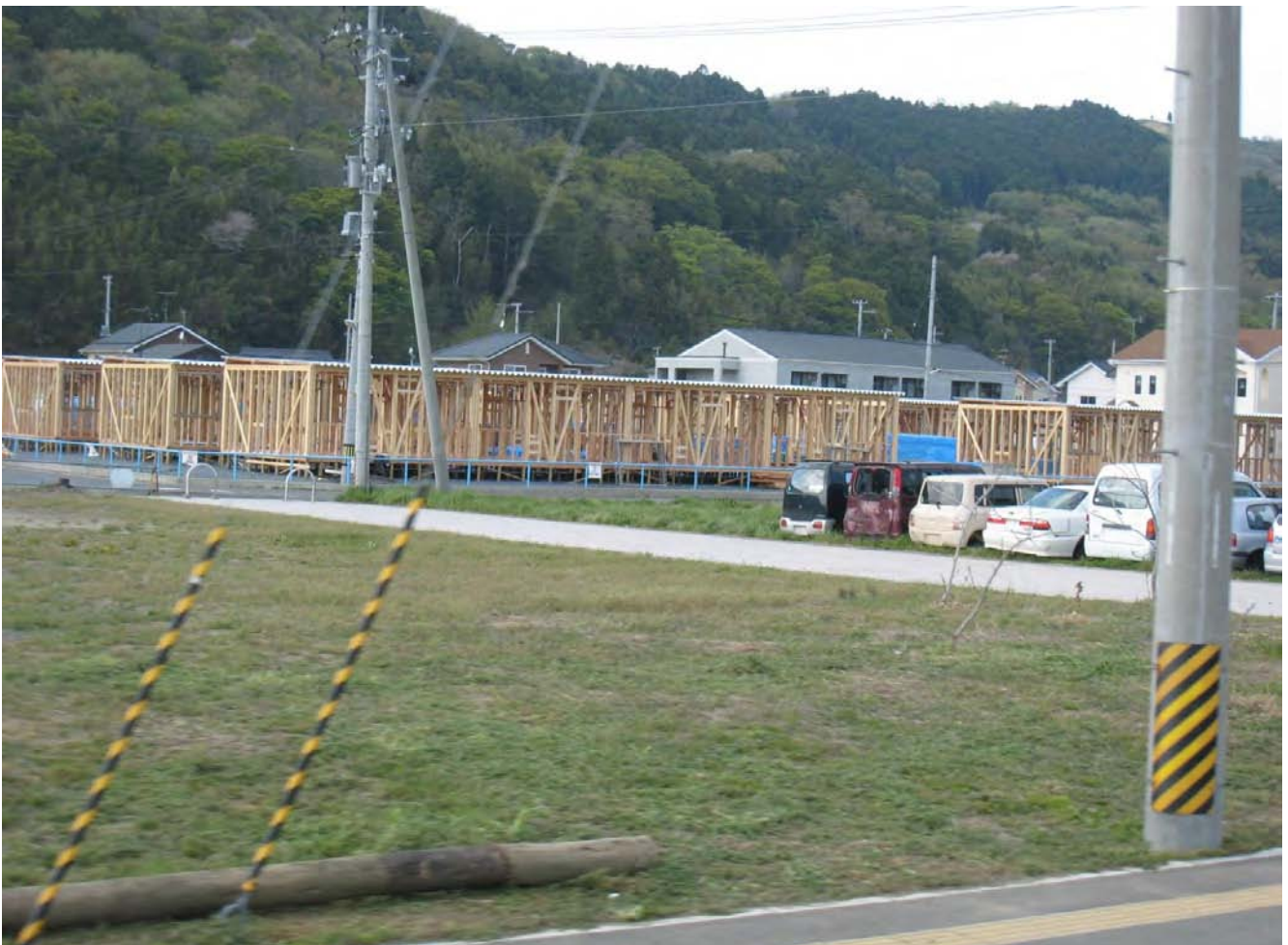
20次隊 建設中の仮設住宅
