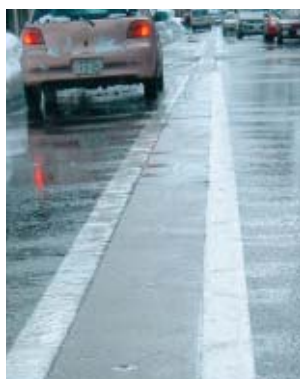
消雪パイプ Pipes to Clear Snow
