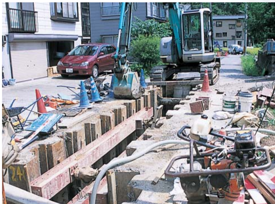
下水道の整備 Sewer Improvement Project
