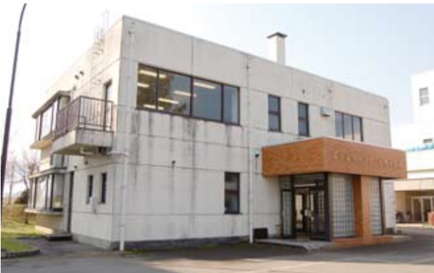
環境衛生センター管理事務所
