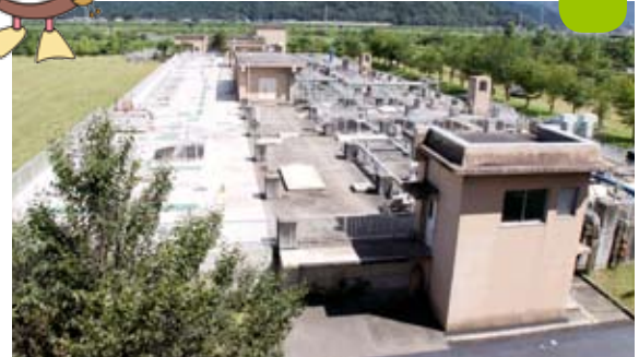
六日町浄化センター〔五日町〕
