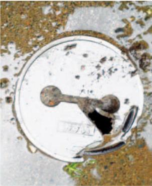
宅地内にある汚水ますに破損がないか点検し、破損がある場合は、すぐに修繕ください。破損があると雨水や融雪水が下水道に流入し、流入水によって処理場での汚水処理に支障をきたします。
