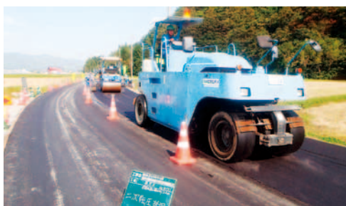
現場作業状況 【転圧】
