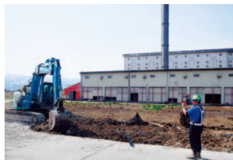
現場作業状況【地盤改良】
