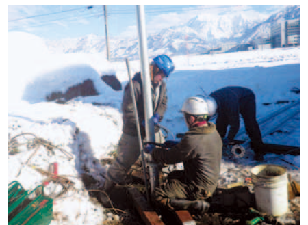
揚水管の建込作業
