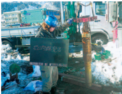
ポンプの引揚作業
