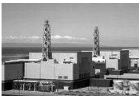
柏崎刈羽原子力発電所
