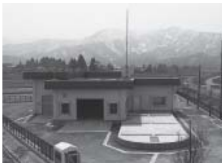
大木六浄化センター
