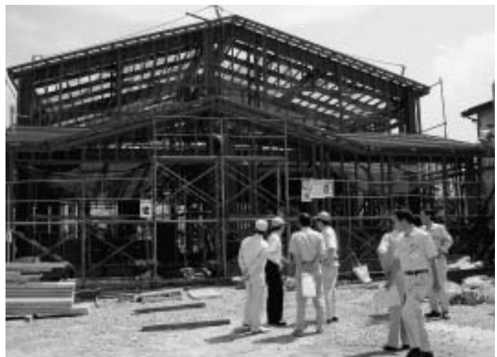
建設中の「セルプこぶし工房」
