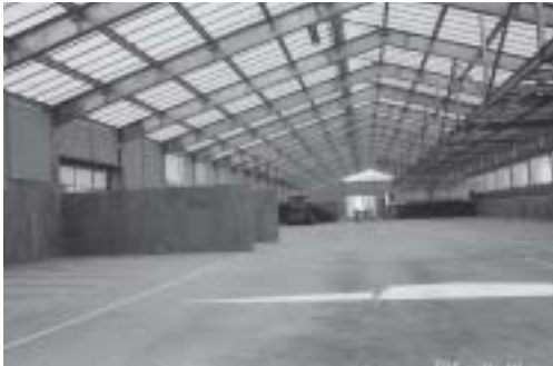
稼働はじめた広域有機センター
