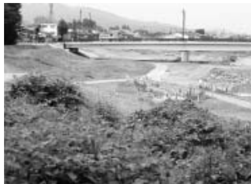
坂戸橋より六日町大橋を望む
