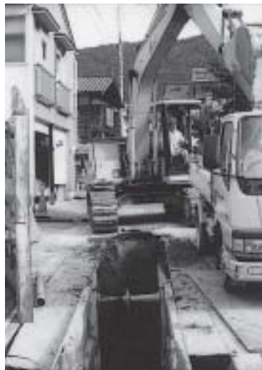
進む下水道工事
