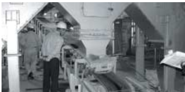
ごみ焼却場内部
