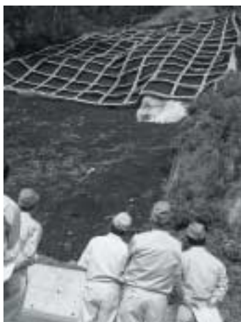
三国川ダム周辺道路復旧工事
