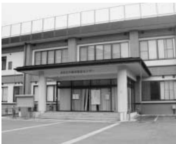
使用停止中の旧福祉センター
