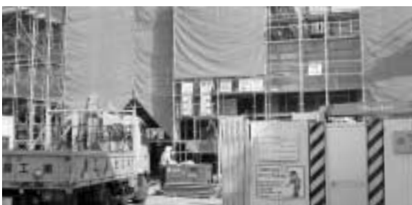
新築中の特養施設
