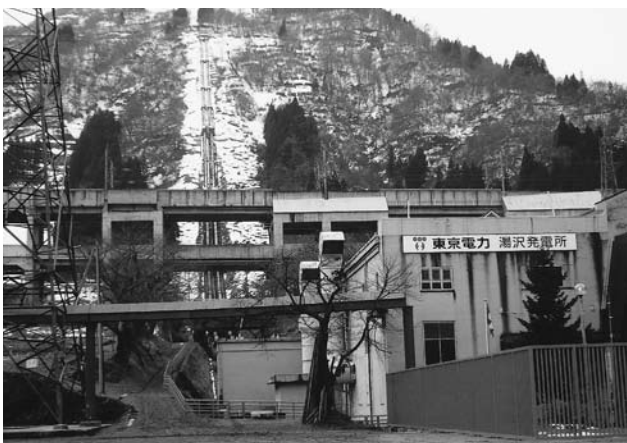
東京電力湯沢発電所
