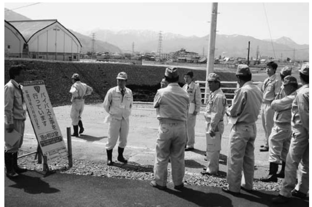
六日町バイパス工事現場
