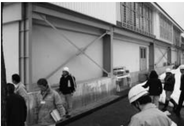
体育館耐震補強状況
