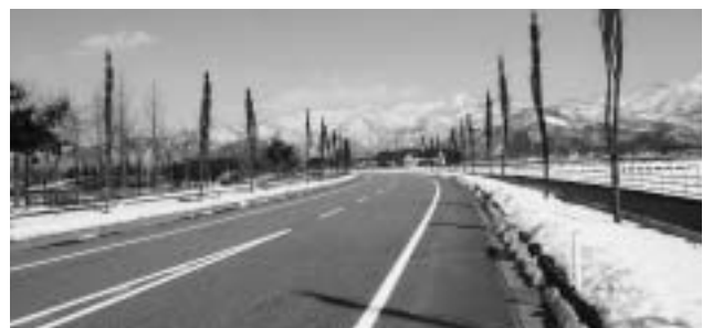
17号浦佐バイパス一部供用区間
