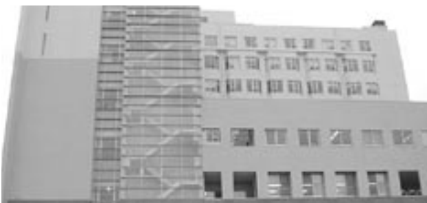
県立新発田病院の救命救急センター
