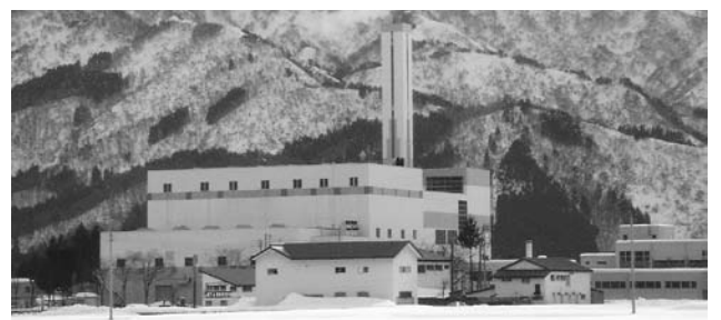
溶融炉がある環境衛生センター（島新田）
