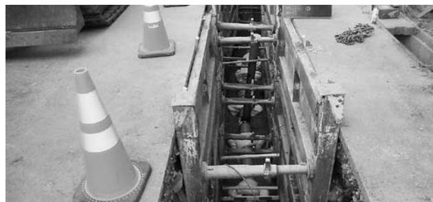
下水道工事現場
