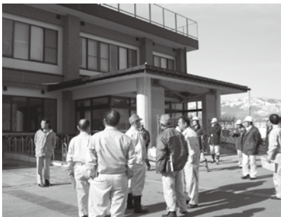
補修改修中のふれ愛支援センター
