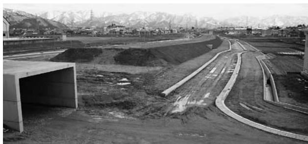
国道17号六日町バイパス工事
