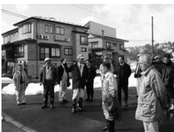
六日町駅裏、消雪パイプ施工状況
