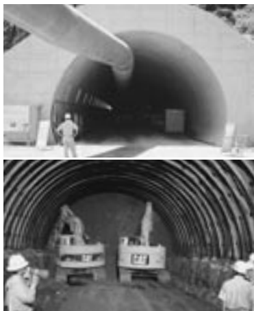
八箇峠トンネル掘削現場
