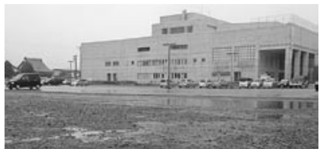
市民会館駐車場
