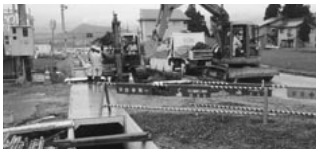
公共工事現場
