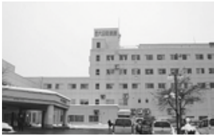
県から市への移譲の協議が始まった六日町病院
