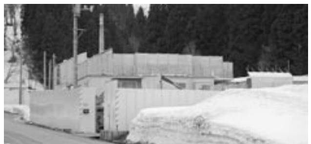
建設が進む新斎場（思川）
