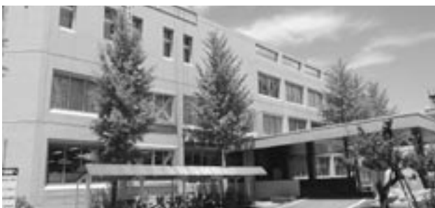
南魚沼市役所 本庁舎
