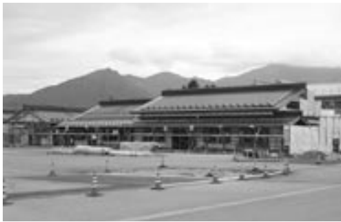
建設中の道の駅（今泉博物館前）
