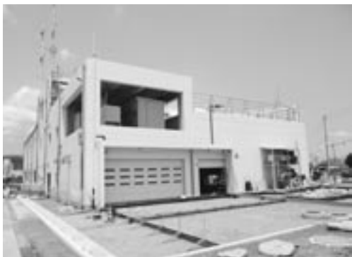
新消防庁舎の建設
