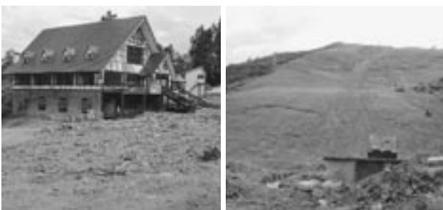
土砂災害にあった上越国際スキー場の観光施設
