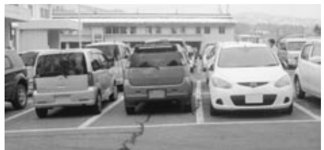
本庁舎南側駐車場
