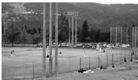
建設工事に入る大原運動公園野球場(万条球場)
