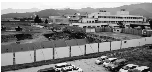
基幹病院工事現場
