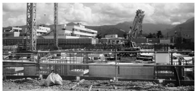
工事中の基幹病院
