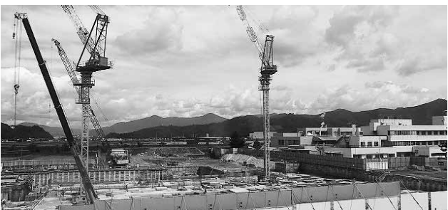
大和病院に隣接して基幹病院建設進む
