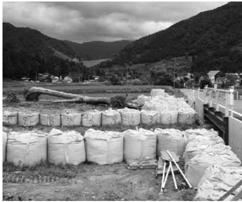
五十沢(土沢)の災害復旧現場
