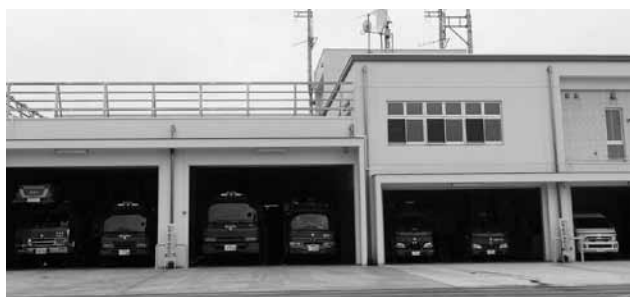
南魚沼市消防本部庁舎
