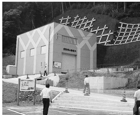
黒部町 宮野用水発電所
