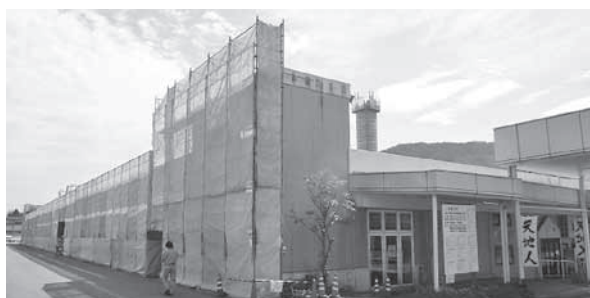
外装も始まった図書館建設工事
