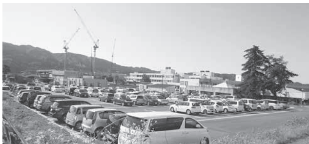
ゆきぐに大和病院、建設中の基幹病院
