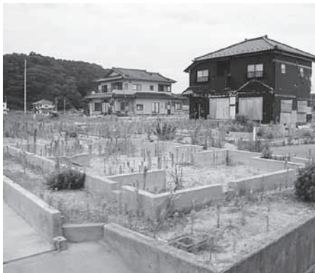
いわき市津波被害地
