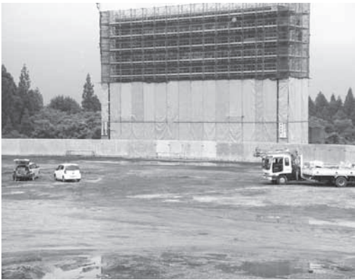
大原運動公園建設状況
