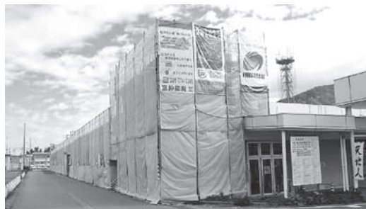
工事が進む新図書館
