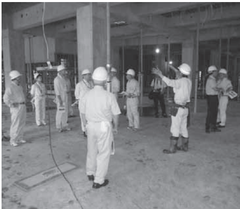
魚沼基幹病院建設現場
