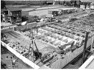
新市立病院建築現場
