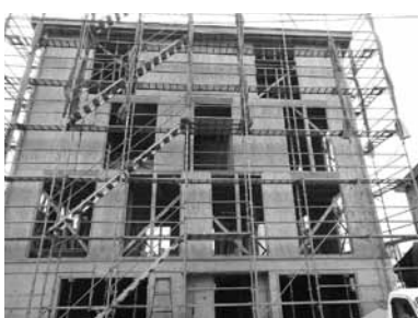
工事中の住宅
