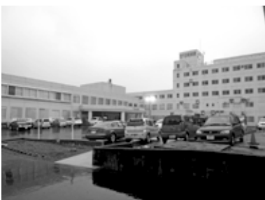
取り壊し予定の旧県立六日町病院
