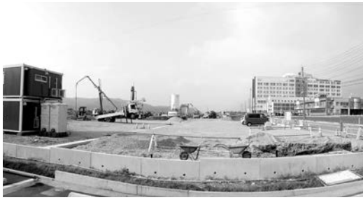
基幹病院周辺の建設現場
