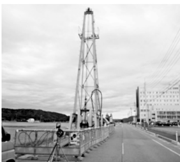
市道の井戸掘削現場
