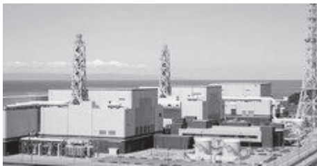
柏崎刈羽原子力発電所
