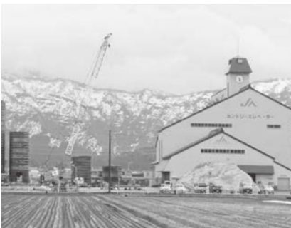
建設中の大和カントリーエレベーター
