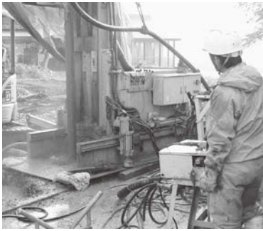
井戸掘削作業
