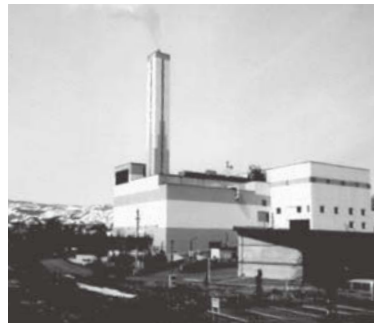
稼働中の可燃ごみ処理施設
