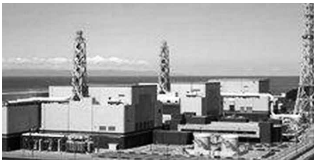
柏崎原子力発電所
