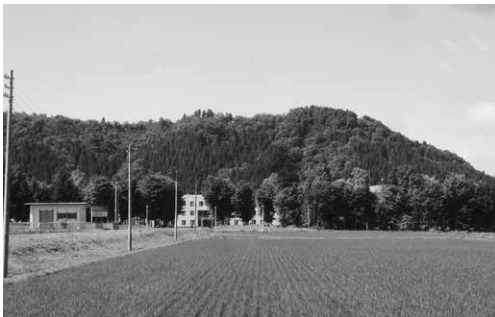
建設予定地を望んで
