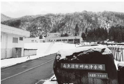
南魚沼市浄水場
