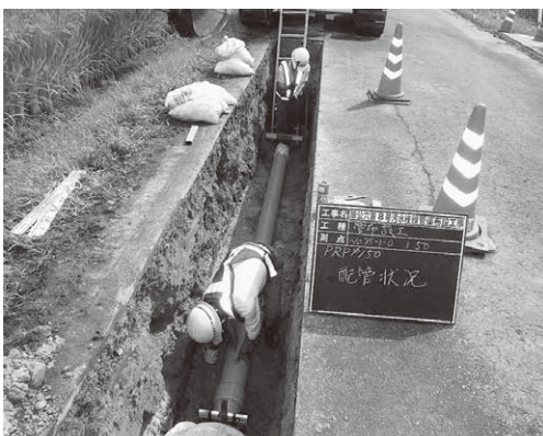
下水道管布設工事
