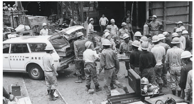
▲ S.52.7.15 新幹線トンネル工事現場火災
