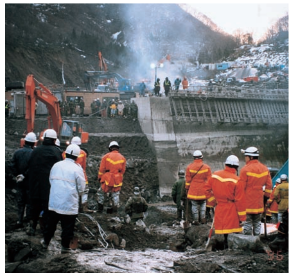
▲長野県蒲原沢土石流災害現場へ応援出場
