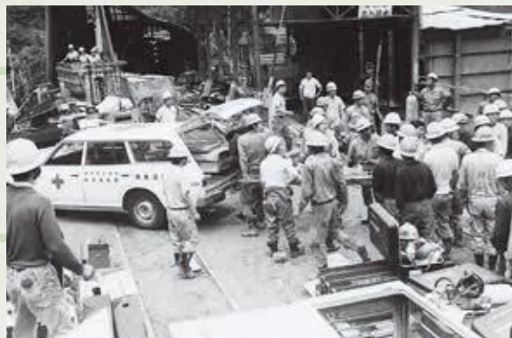
新幹線トンネル工事現場火災
