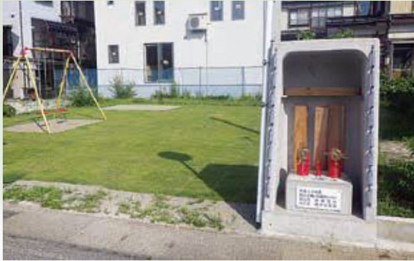
公園内40 t 耐震性貯水槽
