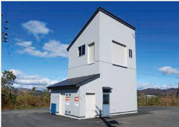
大和分署 訓練塔
