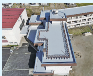
屋上防水・体育館の屋根改修
