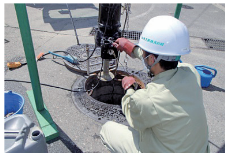
ポンプに詰まったタオルを取り除く作業
