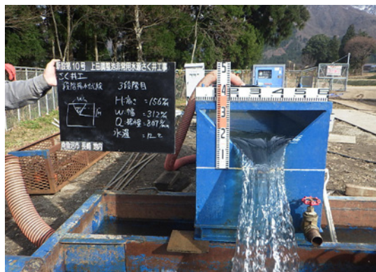
非常用水源整備(井戸)工事の様子
