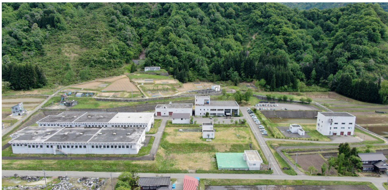
畔地浄水場の全景
