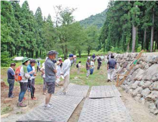
石垣工事現地説明会の様子
