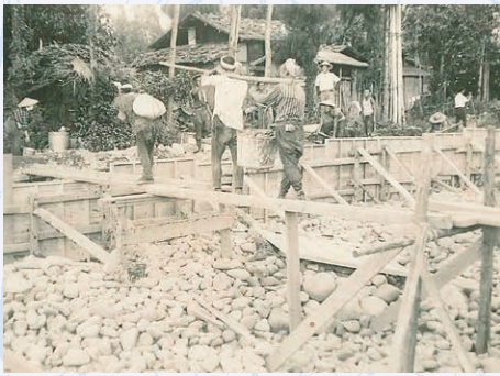
写真③ 大木六小学校プール工事の様子
