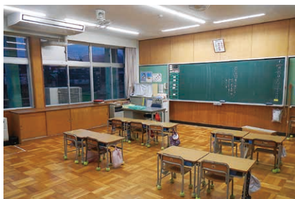
床の張替え、エアコンの設置
